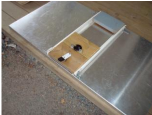
Figur 4 – Rotations- och låsningsanordning monterat på skenorna/expansionsbeslagen i infällt läge.
