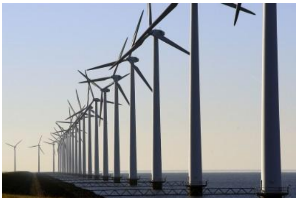
Bild 3. Vindkraftverk som stabiliseras med hjälp av en extern stabilisator. Källa: www.vegania.se
